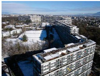
Le complexe d'habitation du Lignon, George Addor, 1966. Crédit photo: Kyle Normandin
