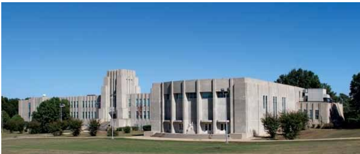
Fig. 1. Fachada concreto arquitectónico expuesto y elementos de concreto en Bailey School, Jackson, Mississippi, diseñado por el arquitecto A. Hays Town y construido en los 1920s. Fotografía 2016.
