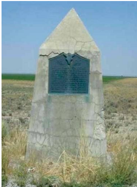
Fig. 9. Patología relacionada con la congelación y el deshielo en un monumento histórico de hormigón expuesto, Wyoming, 2008.
