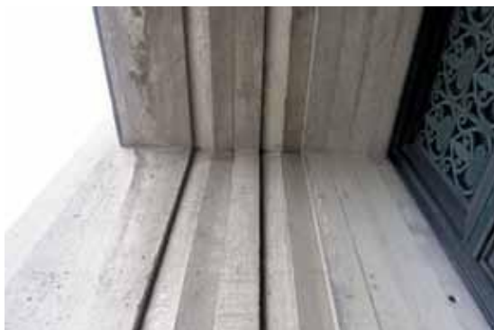
Fig. 4. Acabado de concreto liso.
