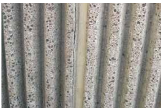
Fig. 6. Acabado de concreto formado por tablero.
