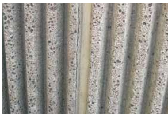
Fig. 6. Acabado de concreto formado por tablero.
